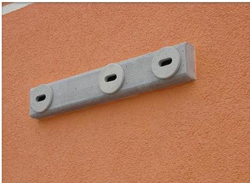
Mauerseglerhöhlen in der Dämmung
