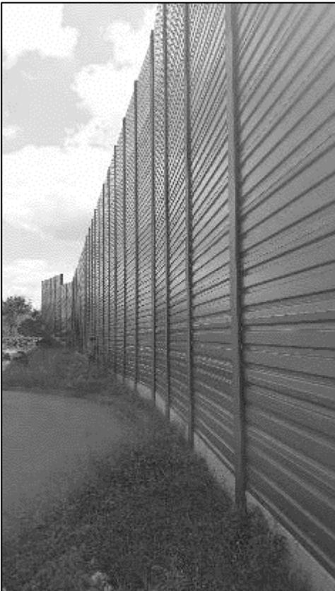
**Abbildung:** Bestehende Lärmschutzwand entlang Bahnstrecke 5860 im Bebauungsplan Nr. 101 (Quelle: Ferdinand Schmack jun. GmbH)
