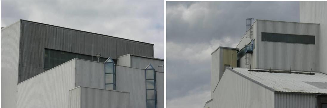
Abbildung 3: Verbliebenes hohes Gebäude, komplett mit Wellblech verkleidet
