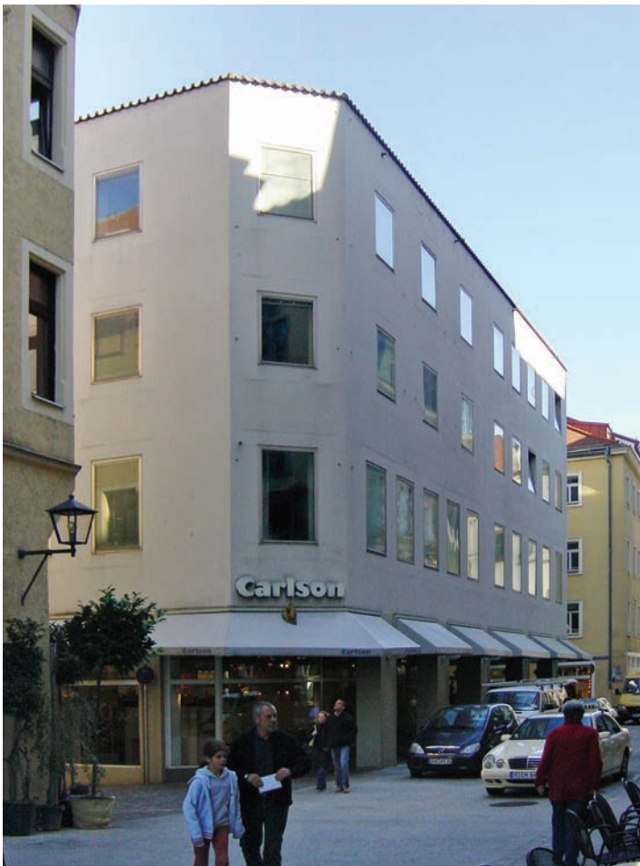
Vor der Sanierung
