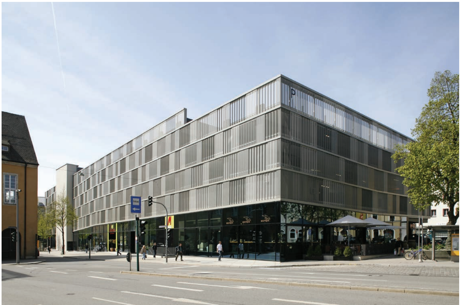
Das Parkhaus am Dachauplatz nach der Sanierung
