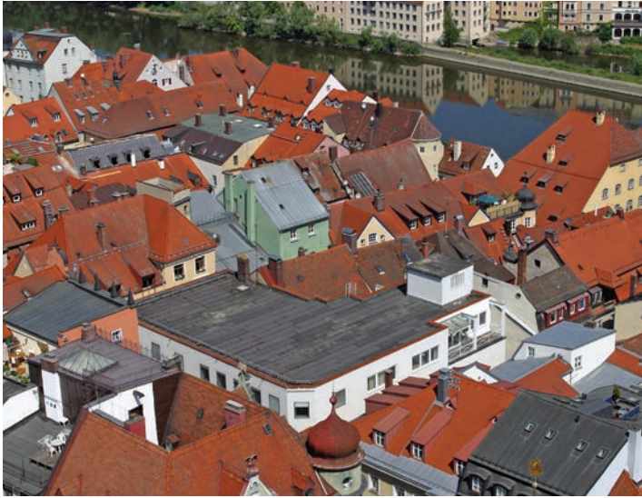
Vor der Sanierung: eine Störung in der Dachlandschaft
